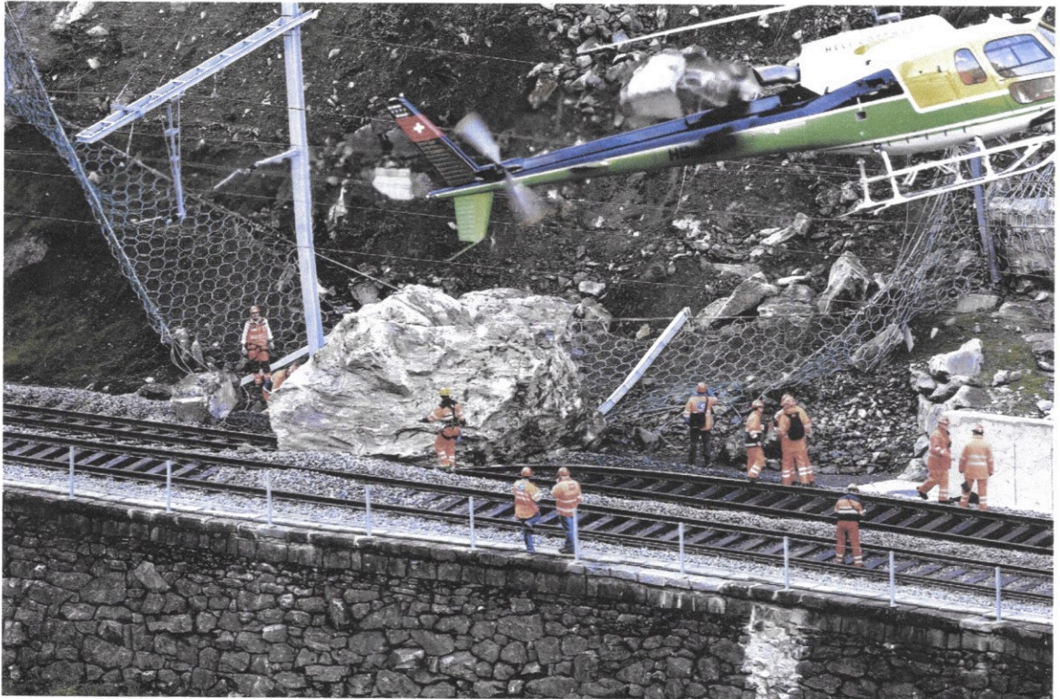
Un important éboulement survenu dans le canton d'Uri, sur un tronçon de la ligne du Gothard. Un tiers du réseau CFF est jugé vulnérable aux risques naturels. (GURTELLEN, 15 NOVEMBRE 2012/URS FLUEELER/KEYSTONE)
